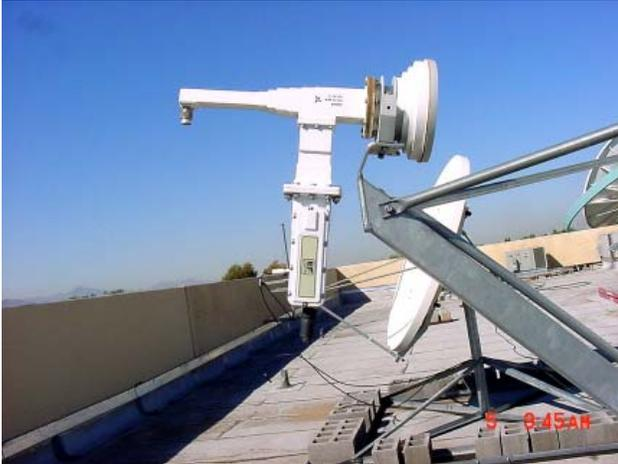
**Figure B-8. Installation of LNA**
